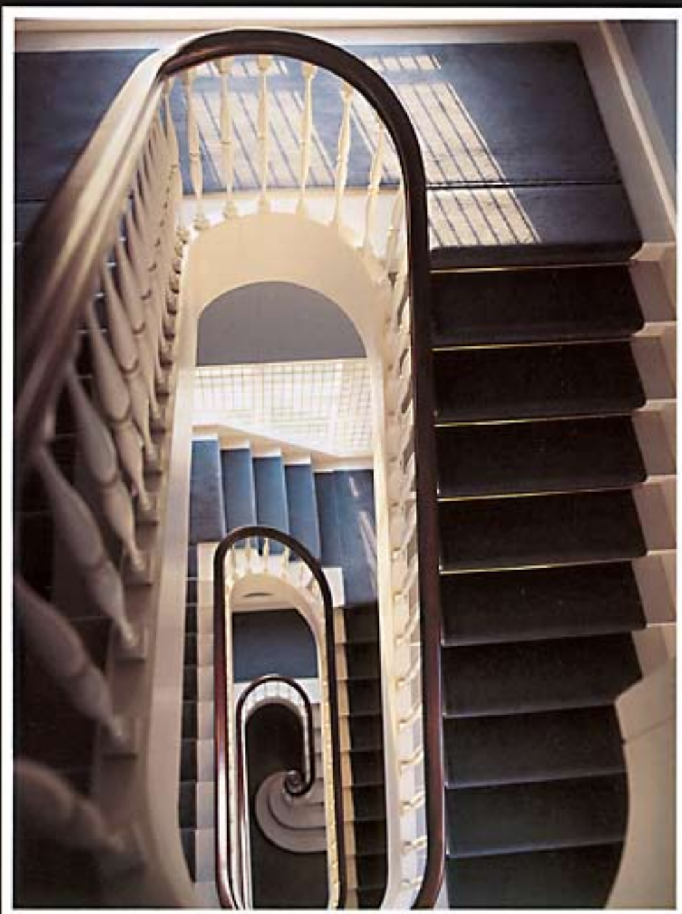
Et kig ned gennem durchsicht'en fra 2. sal. I bunden ses afslutningen, et dobbelt klodstrin.
