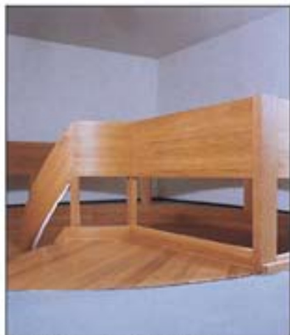
Specialgelænder på vindeltrappe, udført i eg.
